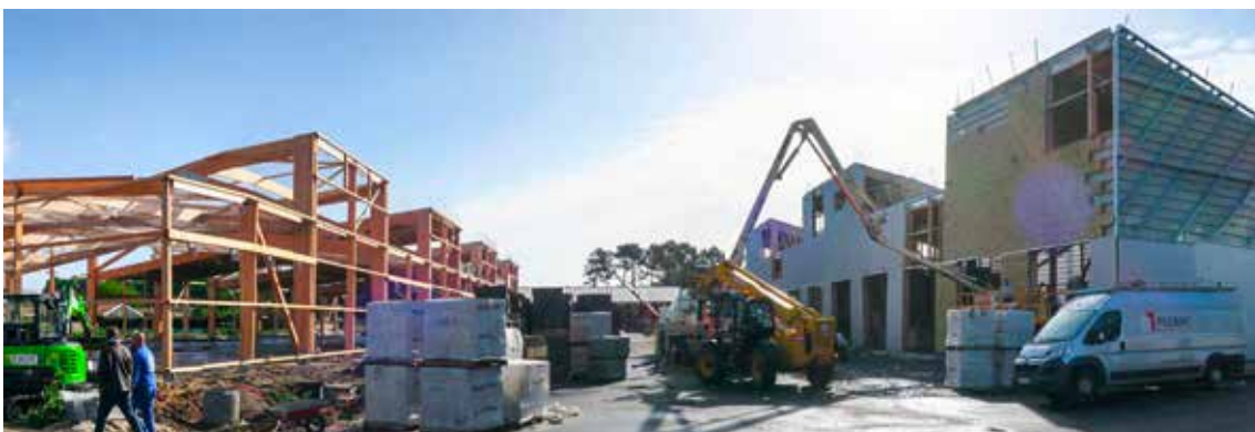
Bâtiments techniques - Crédits photos chantier : Entreprise LAMECOL
